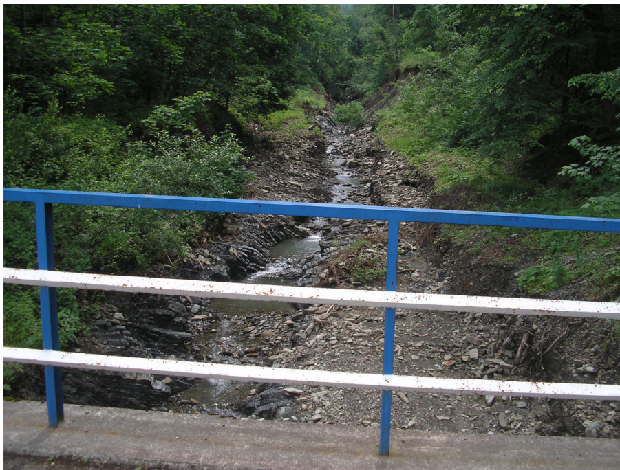
Fot. 6a Rozmyte dno koryta potoku od str. górnej wody
