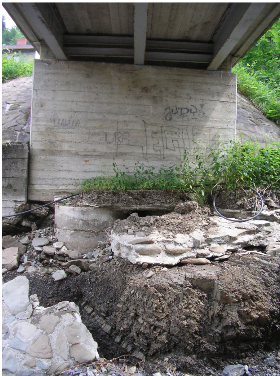
Fot. 4b Podmyty przyczółek prawy (od str. ul. Wielka Puszcza)
