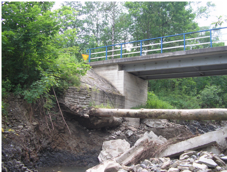
Fot. 5c Uszkodzony prawy stożek od str. dolnej wody
