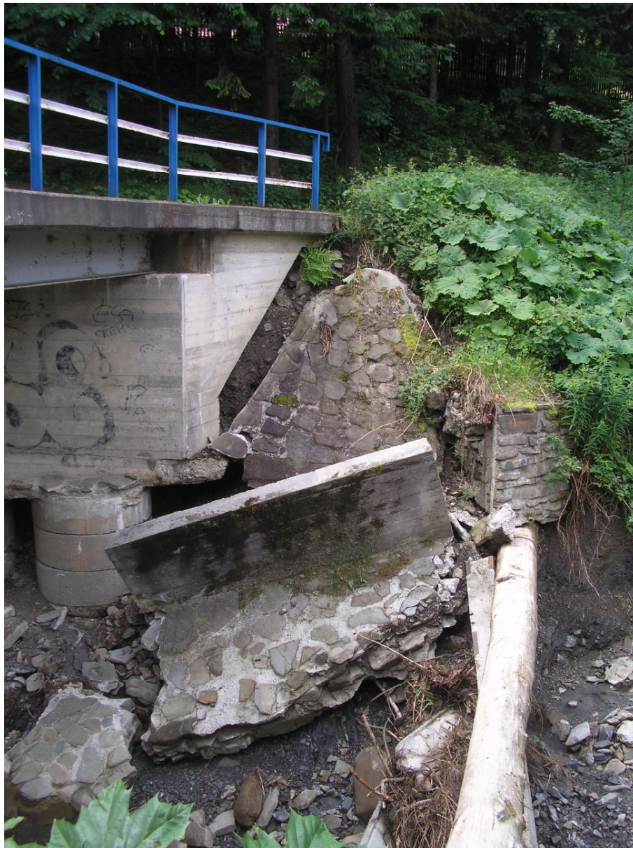
Fot. 5b Uszkodzony lewy stożek od str. dolnej wody
