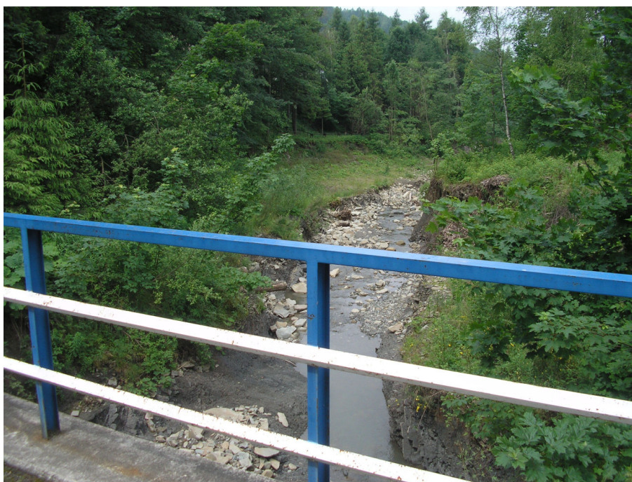
Fot. 6b Rozmyte dno koryta potoku od str. dolnej wody
