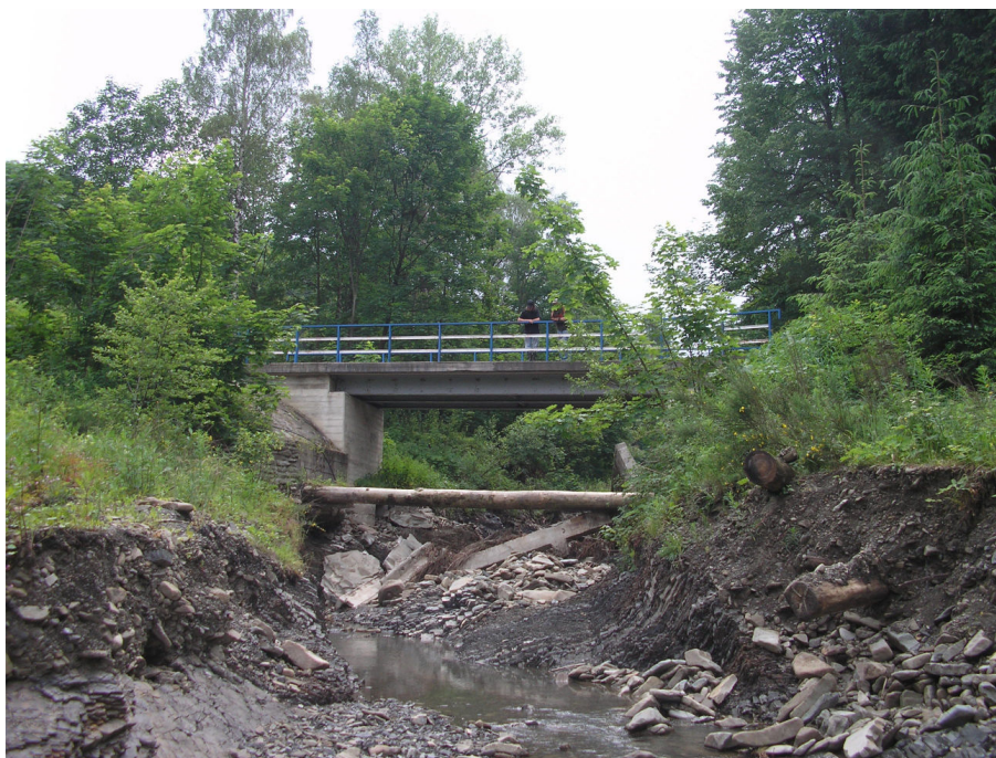
Fot. 6c Rozmyte dno koryta potoku od str. dolnej wody
