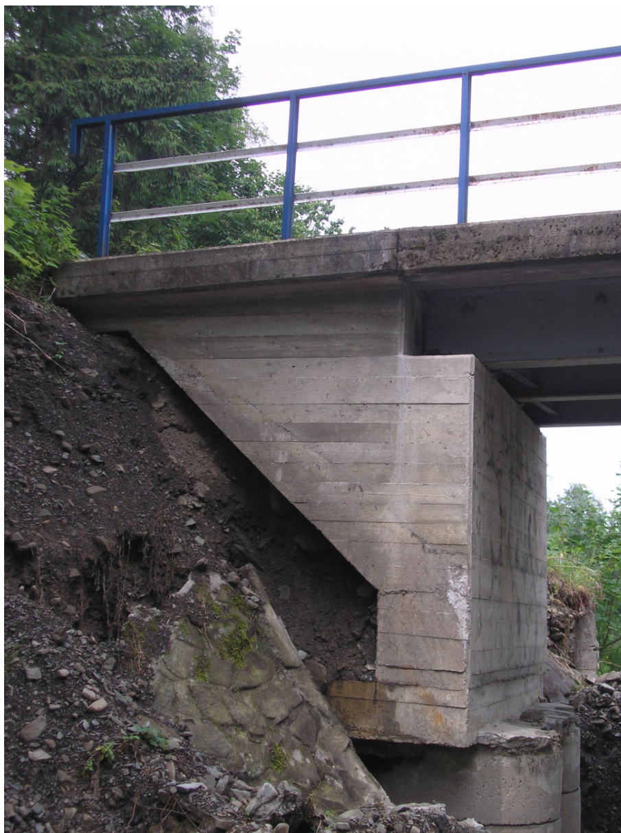
Fot. 5a Uszkodzony lewy stożek od str. górnej wody, ubytki materiału nasypu
