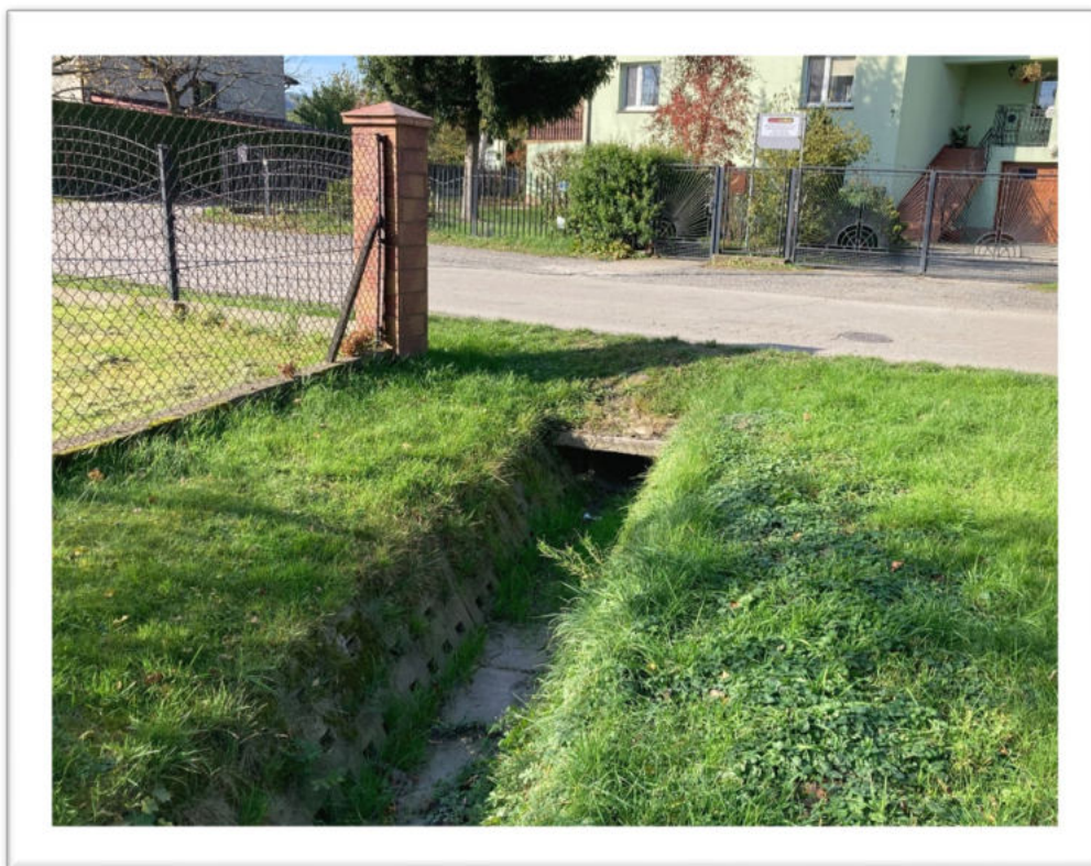
Widok na wylot kanalizacji deszczowej do rowu melioracyjnego odprowadzającej wody opadowe lub roztopowe z rowu przydrożnego ulicy Mieszczyńsko
