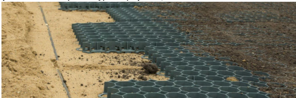
Widok na układaną kratę
