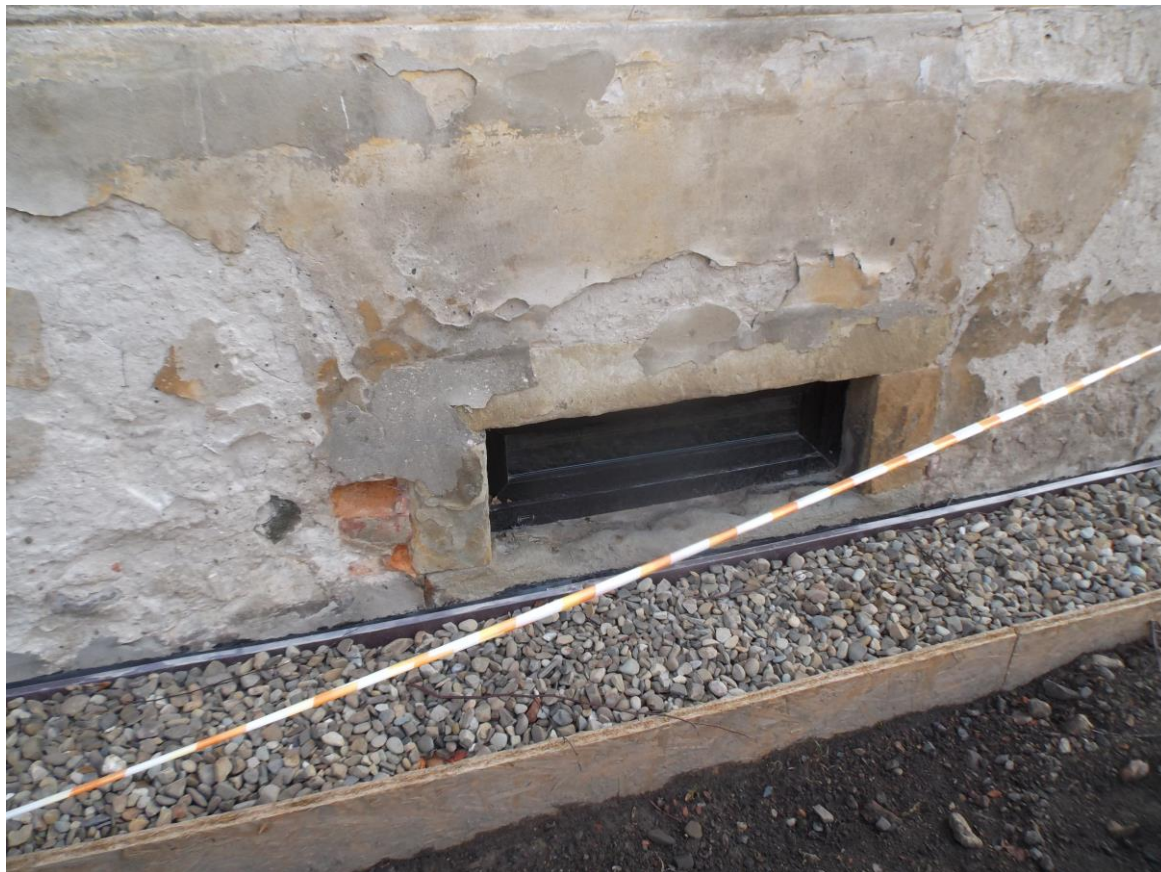
Fot. 6 Elewacja boczna: oprawa kamienna okienka piwnicznego uwidoczniona spod odpadającego tynku
