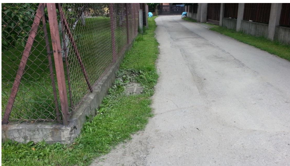
Dojazd do posesji nr 34 ( istniejący wpust chłonny – studnia chłonna )
